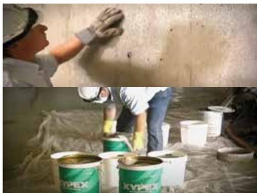
Aplique el **Xypex Modificado**: en condiciones normales de superficie, el rendimiento por cada capa es de 0.65 a 0.8 kg/m<sup>2</sup> (6 a 7.2 pies<sup>2</sup>/lb. ó 1.25 - 1.5 lbs./yd<sup>2</sup>).
