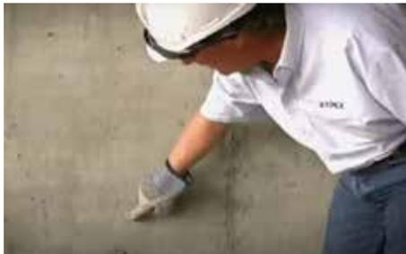
Primero se debe inspeccionar el concreto en busca de defectos, cualquier defecto que incluya grietas, juntas de construcción defectuosas, panal y orificios de amarre. Deben ser reparado antes de la aplicación de **Xypex Concentrado**.
