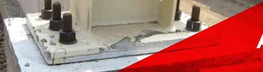
cm. de la placa para permitir el grouteado y la salida de aire y de cualquier remanente de agua.
