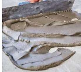
**3** La postura del cerámico requiere ejercer cierta presión, logrando una adecuada nivelación y un contacto efectivo entre el adhesivo y el revestimiento.
