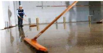
**1** Aplique una película continua mediante un aspersor de baja presión. Para asegurar una penetración máxima, frote el material en la superficie con un cepillo de cerdas duras o con una máquina limpiadora de pisos (min. 30 minutos), hasta que el material comience a gelarse y volverse resbaladizo.
