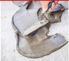
**1** Colocar el adhesivo en una llana dentada y se esparce con la parte plana, presionando para que se impregne en el muro o piso.
