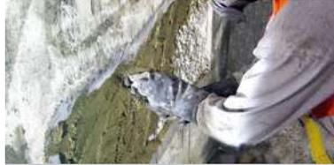
**5** Aplicar PER GROUT MORTAR conforme las recomendaciones del fabricante. Adicionar la cantidad necesaria de agua, hasta obtener una consistencia trabajable.
