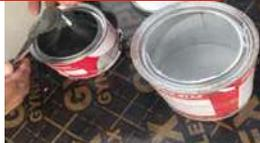
**2** Mezclar los componentes A y B en un recipiente limpio y seco. Revolver en forma manual o mecánica con un taladro de bajas revoluciones. Finalmente se debe obtener una mezcla homogénea.
