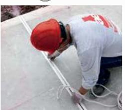
Colocación de cordón de respaldo PER BACKER ROAD 1/4 mas de la medida de la junta.
