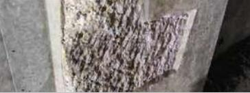
**1** Delimitar el área correspondiente a la falla a través de un corte con sierra amoladora similar Remover el concreto interno de la falla hasta llegar al concreto sano, es decir exento de cualquier tipo de defecto.
