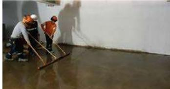
**2** 20 minutos. Después de este proceso elimine cualquier exceso de material mediante un jalador de goma o aspiradora de líquidos. Nunca deje secar los residuos del producto, retirelos inmediatamente ya que son muy difícil de remover si se dejan secar.
