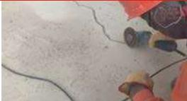
**1** Para el sellado de fisuras realizar corte con disco de concreto rectangulares de 1cm de profundidad por 0.6 a 1 cm de ancho realizar limpieza con presión de aire y humedecer el corte realizado para garantizar la limpieza.
