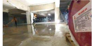
**3** Por lo general sólo se requiere aplicar una capa, sin embargo, en superficies porosas, de textura áspera o con acabado escobillado, podría requerirse una segunda capa. Es recomendable asegurar una máxima densificación superficial del concreto, para evitar la penetración de contaminantes.
