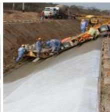
Siguiendo ACI 308 "Las medidas de curado se deben poner en practica tan pronto como el concreto este en riesgo de secarse prematuramente dependiendo de la temperatura donde se trabaje. Se aplican los curadores quimicos tan pronto haya desaparecido el agua superficial del concreto fresco. En el lado de superficies verticales aplicar inmediatamente despues de retirar el encofrado, previo rociado de agua (opcional). Nosotros comercializamos compuestos de curado."
